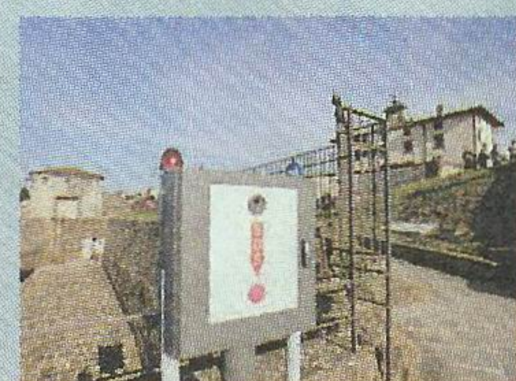
SOS Un'altra delle novità della messa in sicurezza del Forte Belvedere è l'installazione di una colonnina Sos
